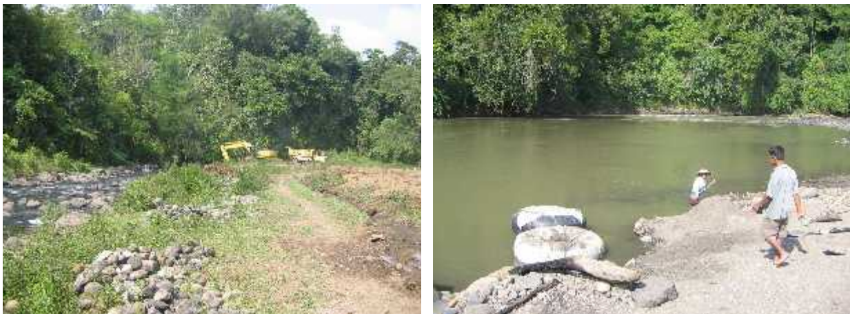
Gambar 2. Kegiatan penambangan batu dan pasir di Sungai Musi bagian hulu (desa Cawang Lamo dan desa Tanjung raya)12
