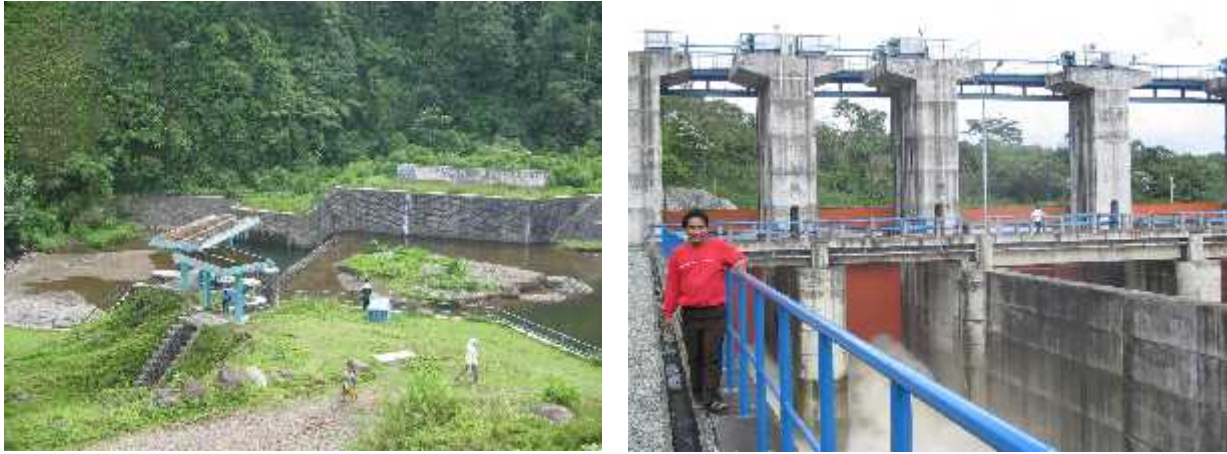
Gambar 4. Bendungan Kejalo (kiri) dan Ujan Mas (kanan) di Propinsi Bengkulu
