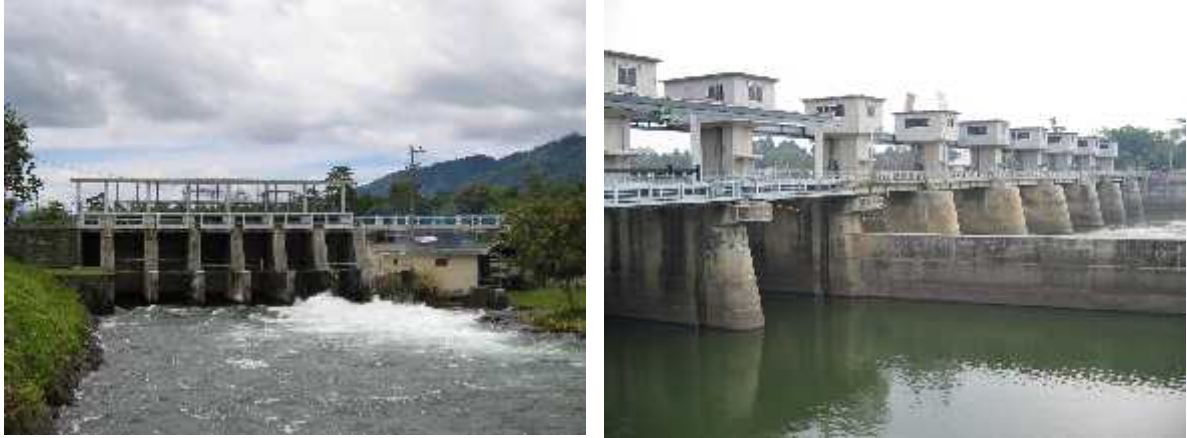
Gambar 5. Bendungan di Sub-DAS Komerling. S. Selabung (kiri) dan Perjaya (kanan)
